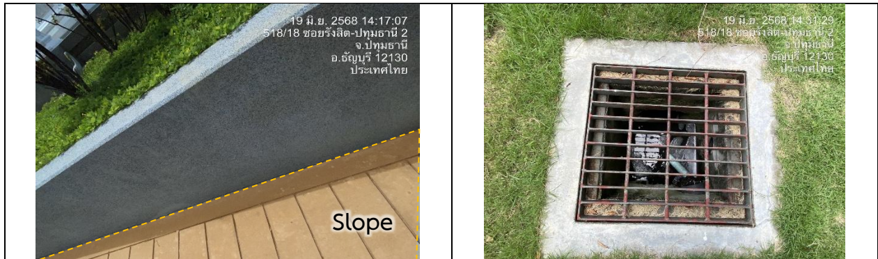
รูปที่ 2-8 ระบบระบายน้ำของโครงการ
