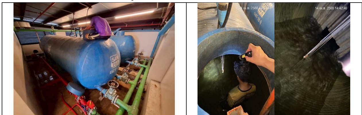
รูปที่ 2-7 การทำความสะอาดถังเก็บน้ำสำรอง
